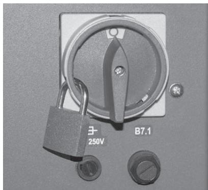
Fig. 3 Mettre l'interrupteur principal en position « O » et le sécuriser contre toute remise en circuit à l'aide d'un cadenas
