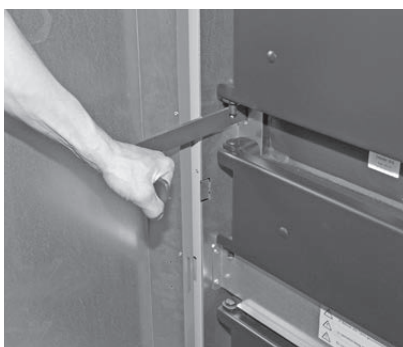
Fig. 18 Activer le levier de nettoyage des surfaces d'échange 5 à 10 fois
