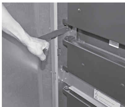
Fig. 36 Activer le levier de nettoyage des surfaces d'échange 5 à 10 fois
