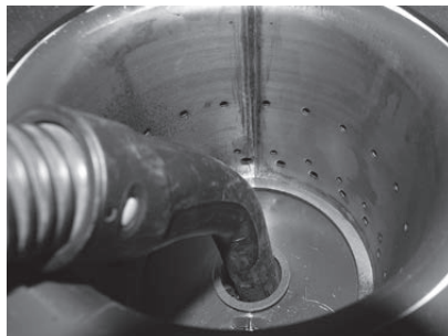
Fig. 78 Aspirer aussi les cendres du tube d'air primaire au milieu du creuset de brûleur
