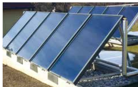
Freiaufstellung/ Flachdachmontage:
