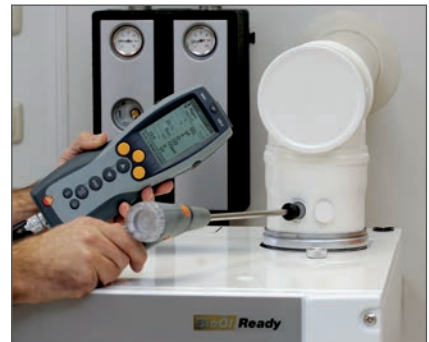
Verkleidung montieren und Verbrennungswerte kontrollieren
