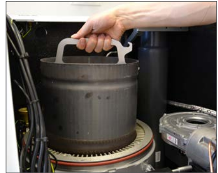
Brennkammer und Verdränger mit Wartungswerkzeug herausziehen
