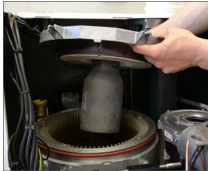
Brennkammerdeckel abnehmen
