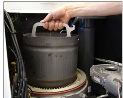
Retirez le pot de combustion et le silencieux à l'aide de l'outil de maintenance
