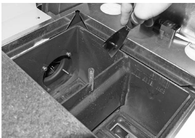
Fig. 72 Nachheizflächen reinigen
