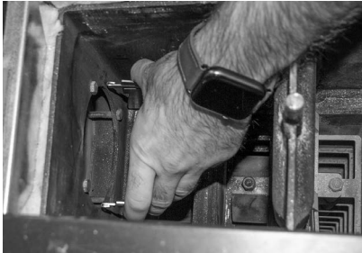
Fig. 68 Umlenblech herausnehmen (nur bei Pelletskessel mit elektrostatischem Staubabscheider)
