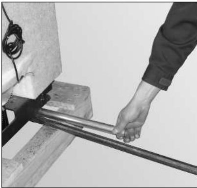
Fig. 8 Eisenrohr unter Kessel platzieren
