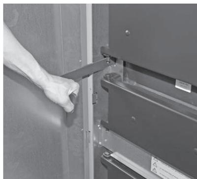
Fig. 52 Activer le levier de nettoyage des surfaces d'échange 5 à 10 fois – LogWIN Klassik pellet ready
