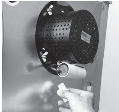
Fig. 34 Gebläsestecker abziehen und Flügelmuttern entfernen
