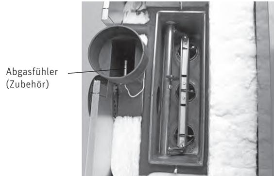
Fig. 38 Nachheizflächen oben reinigen
