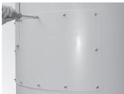
Fig. 79 Deckel bei Vorratsbehälter lösen
