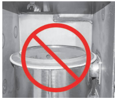
Fig. 66 Brennkammer NICHT reinigen oder auseinanderbauen – Beschädigungsgefahr!
