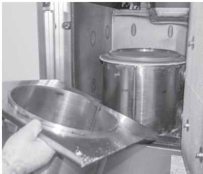
Fig. 65 Flammrohr entfernen und Brennraum reinigen
