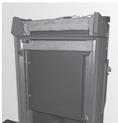
Fig. 67 Isolierung aufstecken – PuroWIN PW 24–60
