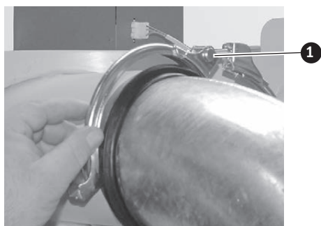
Fig. 202 Mit Dichtung und Spannring-Bögen befestigen 1..... Verschraubungsseiten
