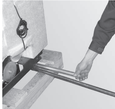
Fig. 13 Eisenstange unter Kessel platzieren
