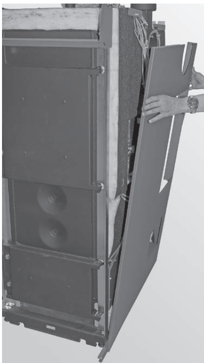
Fig. 50 Seitenwand einhängen
