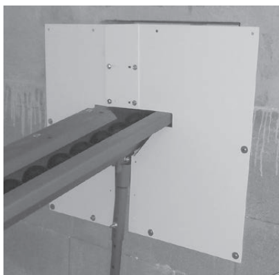
Fig. 170 Abdeckbleche innen montieren
