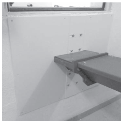
Fig. 171 Abdeckbleche außen montieren
