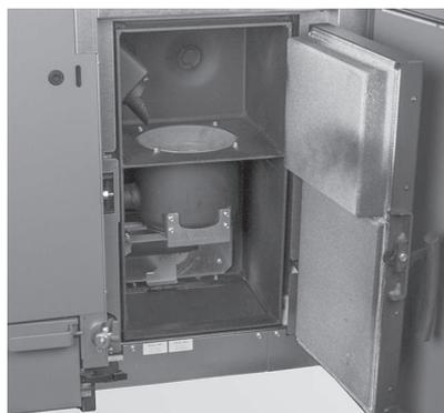
Fig. 37 Ouvrir la porte de revêtement et la porte de la chambre de combustion
