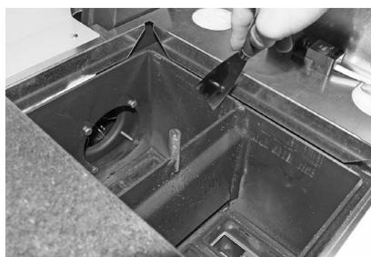
Fig. 72 Nettoyer les surfaces d'échange
