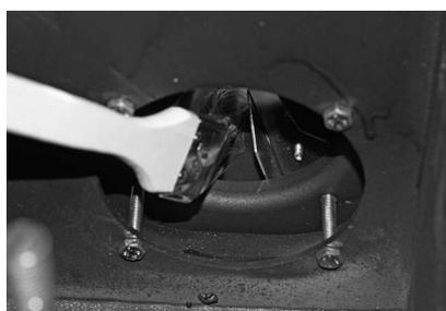
Fig. 70 Nettoyer la roue de ventilation et aspirer
