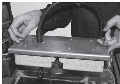
Fig. 67 Soulever le couvercle, ne **PAS** débrancher le câble - Chaudière à pellets avec dépoussiéreur électrostatique
