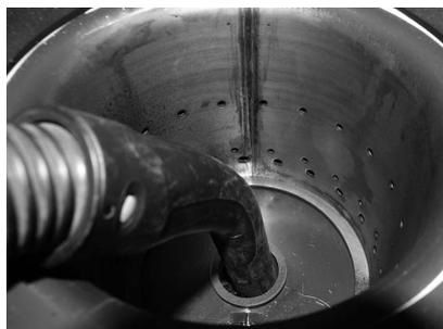
Fig. 59 Aspirer aussi les cendres du tube d'air primaire au milieu du creuset de brûleur
