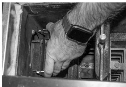
Fig. 68 Retirer le déflecteur (uniquement pour les chaudières à pellets avec dépoussiéreur électrostatique)
