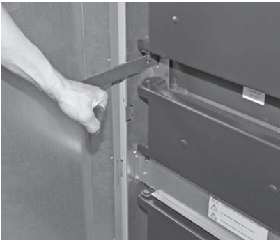
Fig. 56 Activer le levier de nettoyage des surfaces d'échange 5 à 10 fois
