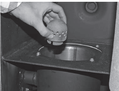
Fig. 96 Retirer la broche d'air primaire
