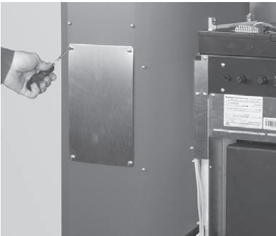
Fig. 114 Enlever les vis, retirer le couvercle de révision
