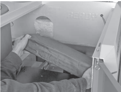
Fig.105 Isolierung entfernen
