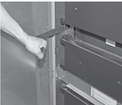
Fig. 56 Hebel-Heizflächenreinigung 5–10 x betätigen
