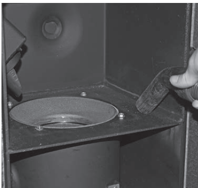
Fig. 90 Verbrennungsrückstände aus dem Brennraum entfernen
