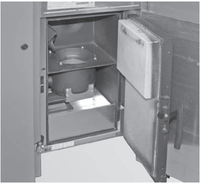
Fig. 77 Verkleidungstür und Brennraumbür öffnen
