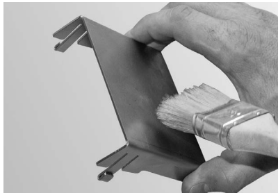
Fig. 71 Umlenblech reinigen (nur bei Pelletskessel mit elektrostatischem Staubabscheider)
