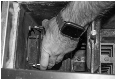
Fig. 70 Umlenblech herausnehmen (nur bei Pelletskessel mit elektrostatischem Staubabscheider)
