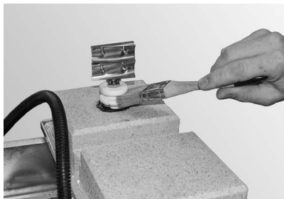
Fig. 73 Elektrode reinigen (nur bei Pelletskessel mit elektrostatischem Staubabscheider)
