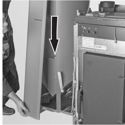
Fig. 84 Blende nach unten schieben und abnehmen (Bajonettverschluss)
