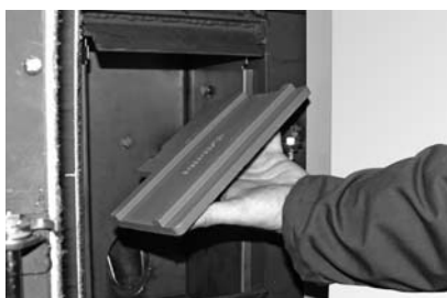
Umlenkplatte herausnehmen, reinigen
