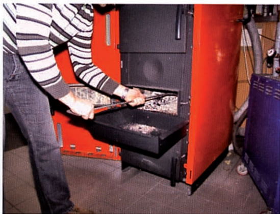
Mit der einhängbaren Aschelade bleibt der Heizraum sauber.
