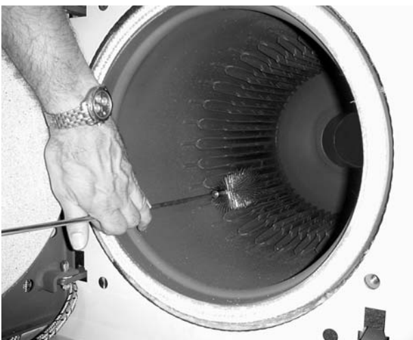
Abb. 13 Konvektionsrippen reinigen
