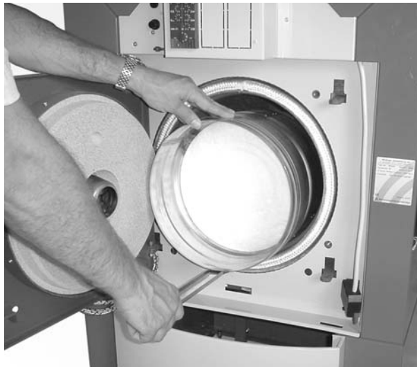
Abb. 12 Edelstahlbrennkammer herausziehen
