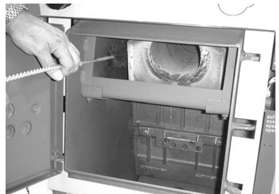
Abb. 10 Nachheizflächen reinigen
