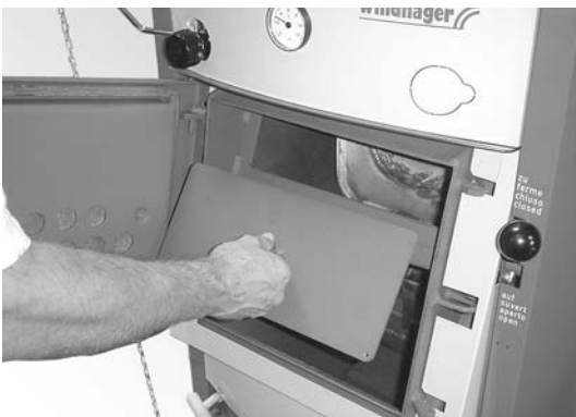
Abb. 9 Reinigungsdeckel herausnehmen
