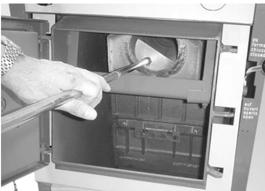
Abb. 11 Rauchrohr reinigen
