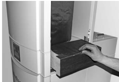
Abb. 142 Isolierung über Heizflächendeckel herausnehmen
