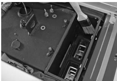
Abb. 145 Heizflächen oben und Gestänge reinigen
