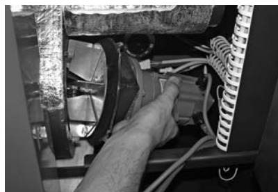
Abb. 150 Flügelmuttern entfernen, Gebläseeinheit herausnehmen
