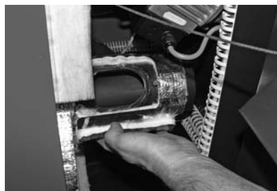
Abb. 152 Flügelmuttern und Reinigungsabdeckung entfernen - Abgasrohr reinigen
