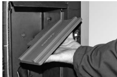
Abb. 127 Umlenkplatte herausnehmen, reinigen
