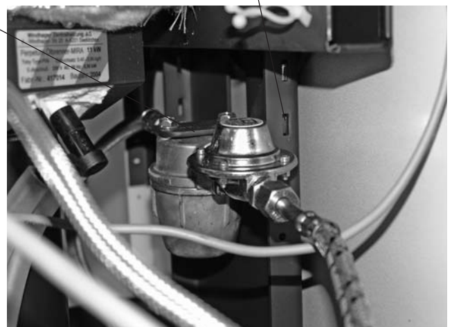
Bild 14b Filtereinheit in Serviceposition – Ansicht von vorne
