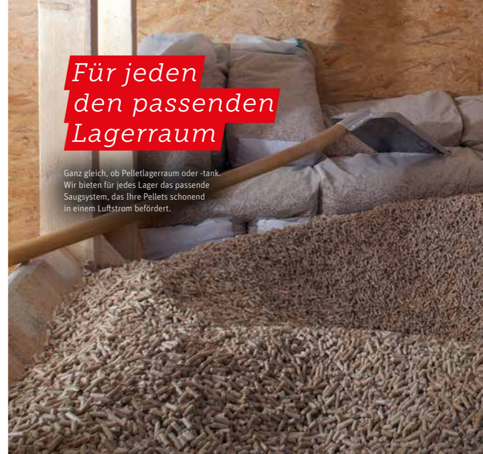
Feuchtigkeit lässt Pellets stark aufquellen, daher muss der Lagerraum trocken sein.
