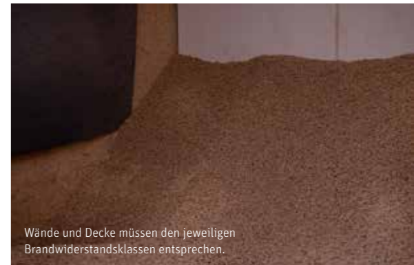
Feuchtigkeit lässt Pellets stark aufquellen, daher muss der Lagerraum trocken sein.
