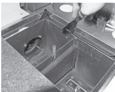
Fig. 83 Nachheizflächen reinigen
