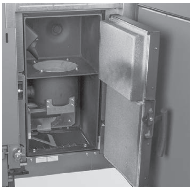
Fig.7 Brennraumbürste während des Befüllvorganges öffnen
