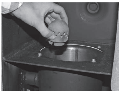
Fig. 59 Primärluftdorn herausnehmen
