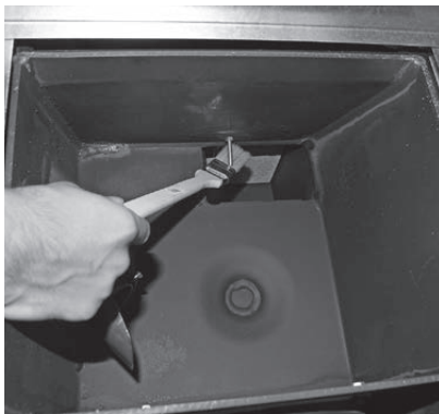
Fig. 51 Thermocontrol-Fühler reinigen
